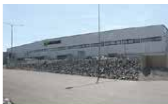
Zentrale - Rosersberg, Schweden
